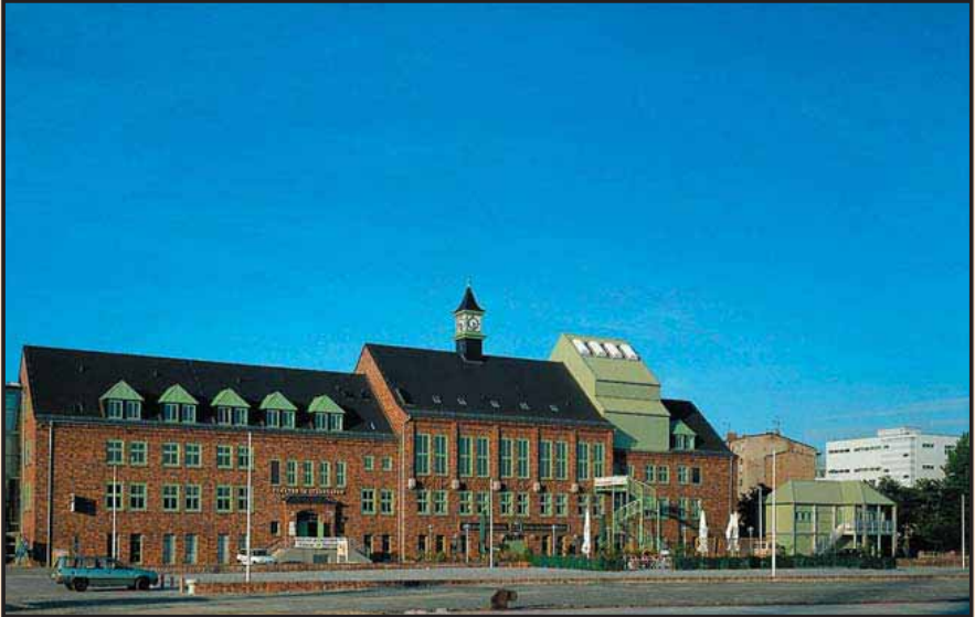
Gesamtansicht des Hafenhauses von der Wasserseite nach dem Umbau 1998
