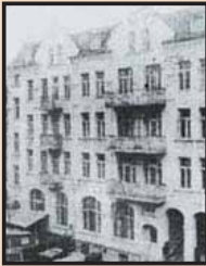
Ehem. Gewerkschaftshaus (Patriotischer Weg 33-35)
